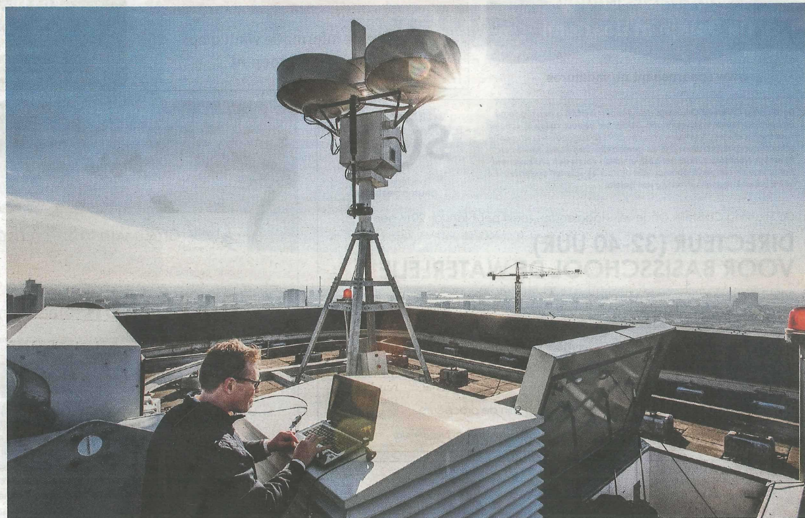
Een technicus inspecteert de werking van de regenradar op het dak van de Delftse Poort.
